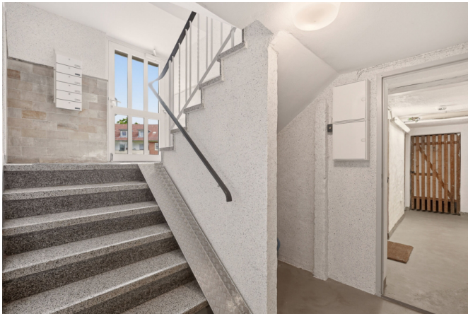
Treppenhaus in den Keller
