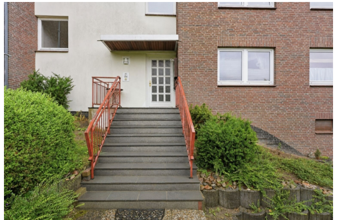
Treppe zum Hauseingang
