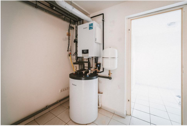
Wohnung 2 neue Heizung mit Ausgang zum
