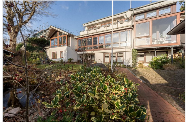
Gartensicht auf das Wohnhaus
