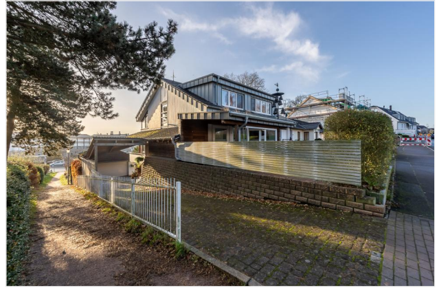
Zufahrt zum Grundstück und zur Doppelgarage
