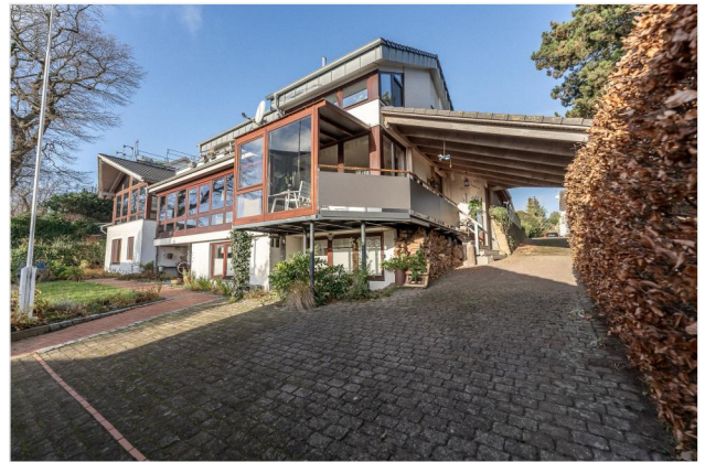
Zufahrt zur Garage mit überdachter Durchfahrt
