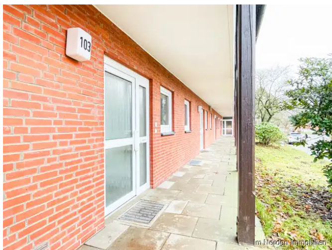
Zugang zur Wohnung
