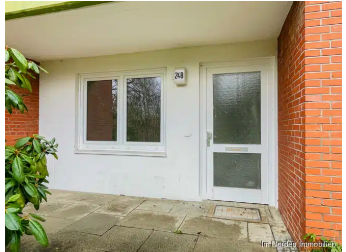
Wohnungseingang und überdachte Terrasse
