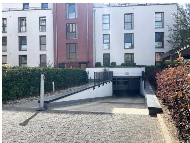
Zugang zur Tiefgarage
