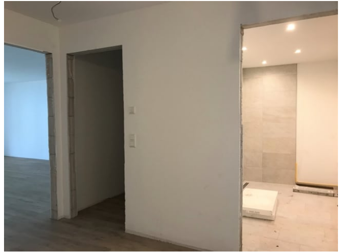
Blick Flur Abstellraum Bad
