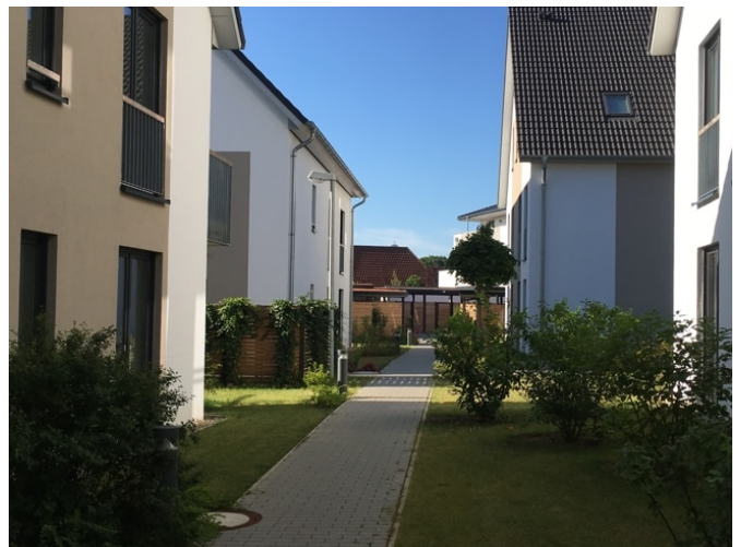
Weg zur Carportanlage
