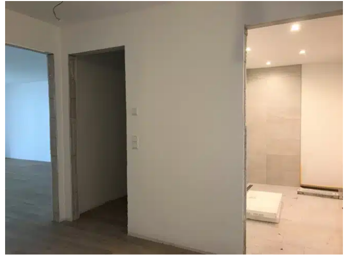
Blick Flur Abstellraum Bad
