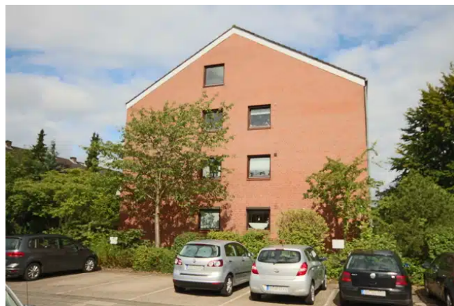
Parkplatz vor dem Haus
