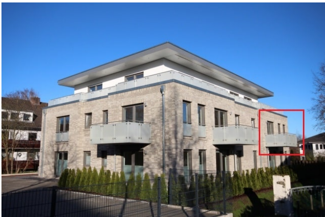
Ansicht von der Riemannstraße
